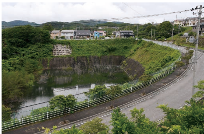
▲みずきが丘住宅内の広大な調整池の全容
