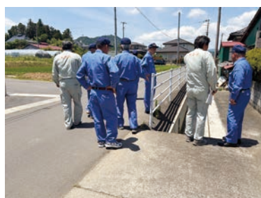
▲鍋田2号線用悪水路改良工事現場
