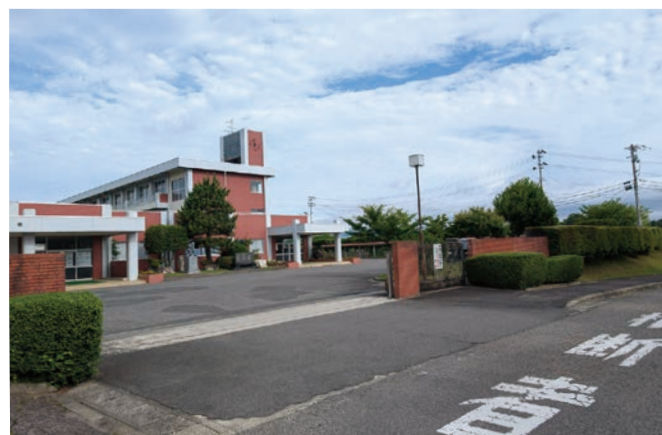
▲学校の安全対策は
