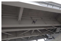
ドローンによる桁下の点検
