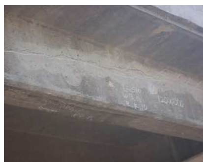
9.千代田橋：プレテンT桁橋 (橋長：32.60m、1954年竣工) プレテン桁の橋軸方向ひびわれ・うき ※雨水の浸入により、損傷は進行する可能性が高い。(迂回路有り)
