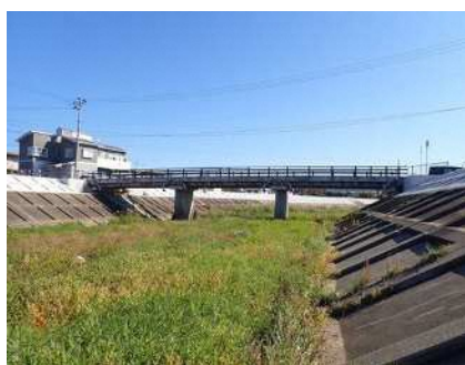
9.千代田橋：プレテンT桁橋 (橋長：32.60m、1954年竣工) プレテン桁の橋軸方向ひびわれ・うき ※雨水の浸入により、損傷は進行する可能性が高い。(迂回路有り)
