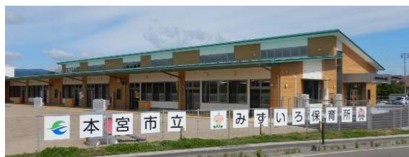
みずいる保育所（令和4年移転新築）
