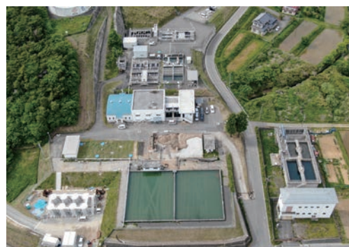
▲施設の改修が進められている立石山浄水場
