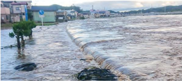
南から北へと向かう阿武隈川の流れと台風の進路が並行となり、水かさが持続的に急増したことから、計画高水位を超過し、堤防のかさ上げが未了であった上町地区から下町地区の約700m区間で越水が発生。
