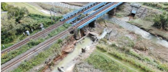
安達太良川の水が本流である阿武隈川との合流地点で行き場を失い、逆流してあふれ出す「バックウォーター現象」が発生。阿武隈川と安達太良川の合流付近（合流部より約500m上流）の左岸側（JR東北本線と北川原田樋門）で堤防が決壊し、市内中心部では、内・外水の双方での浸水が発生した。
